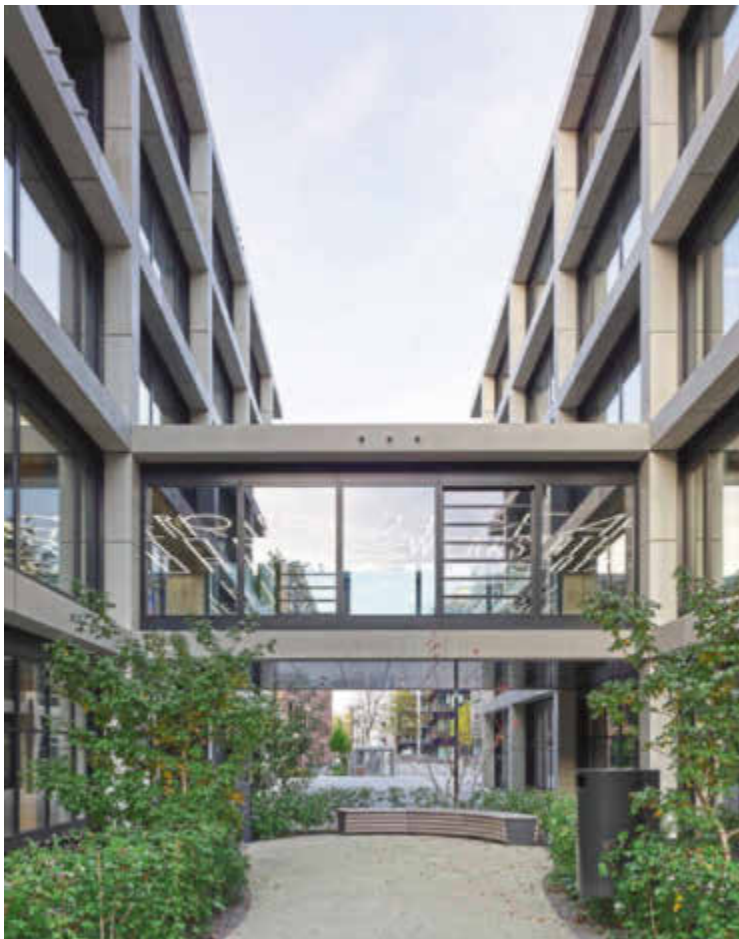
Außenansicht zweier Gebäudeteile mit verbindender Magistrale.
